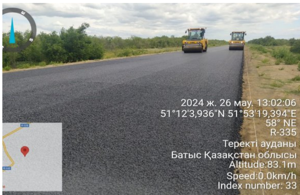
Рисунок 3 – Уплотнение полимер-щебеночно-мастичной асфальтобетонной смеси
