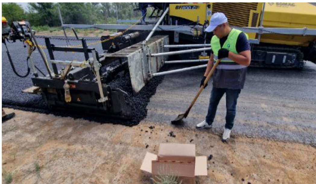
Рисунок 4 – Отбор проб асфальтобетонной смеси
