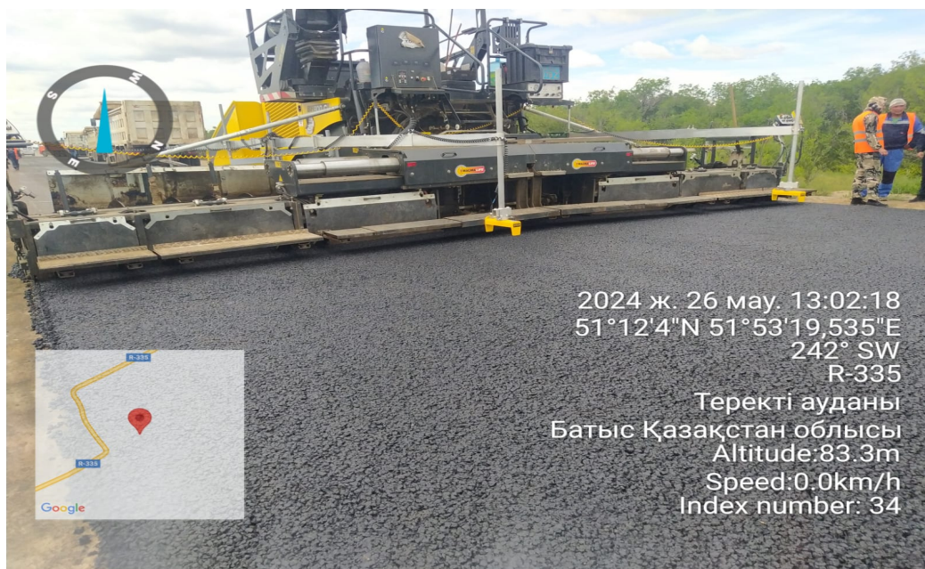
Рисунок 2 – Укладка полимер-щебеночно-мастичной асфальтобетонной смеси
