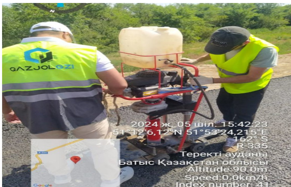
Рисунок 6—Отбор проб кернов
